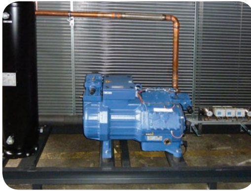
Kondensations-Trocknungsanlage zum durchschlagenden Erfolg
